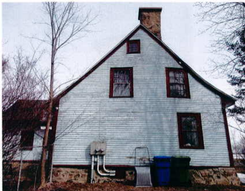
Photo no.10: Bombement dans le mur extérieur
