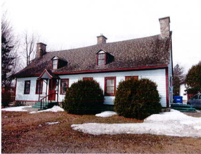
Photo no.1 : Vue en élévation du bâtiment existant situé au 22-24 rue Martel à Chambly
