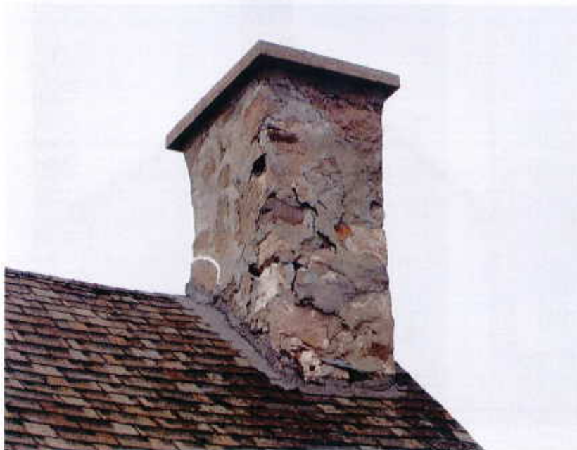
Photo no.8 : Rejointoiement des pierres des deux cheminées.
