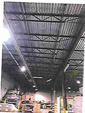
Photo 1 : Vue du plafond
